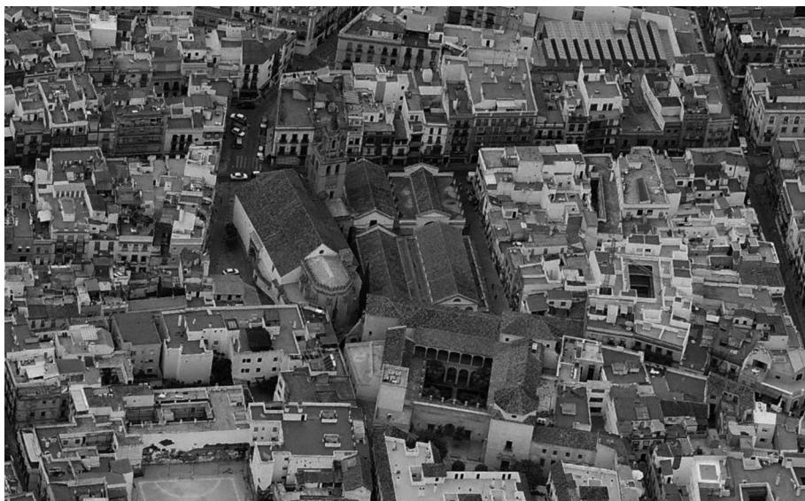
Fig. 2. Vista aérea de la Plaza Calderón de la Barca, Sevilla.
