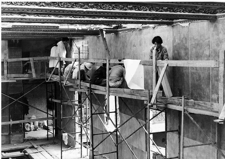
Fig. 32. Pegado de telas en la superficie pictórica para extraer la película de color de la pared.
