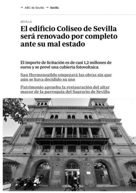
Fig. 21. Recientemente un periódico escribía sobre deficiencias en el mantenimiento del Edificio Coliseo de Sevilla
