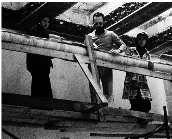
Fig. 33. Desprendida la tela del muro juntamente con la pintura es enrollada para el transporte.
