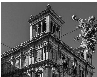
Fig. 13. El diseño del Coliseo incorpora el ladrillo rojo visto, la columna de mármol blanco y la cerámica.
